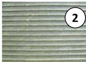
Außenseite - feine Rillen
