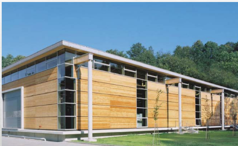
NiroSan® Edelstahl-Fittingwerk in Schmiedefeld bei Dresden
